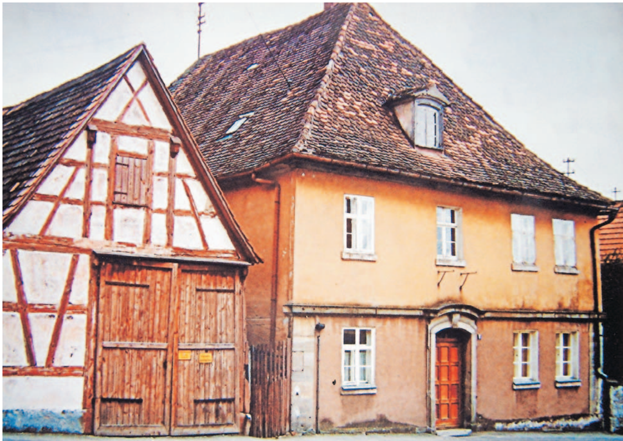
1970 wurde das alte Schwander Pfarrhaus abgerissen.
